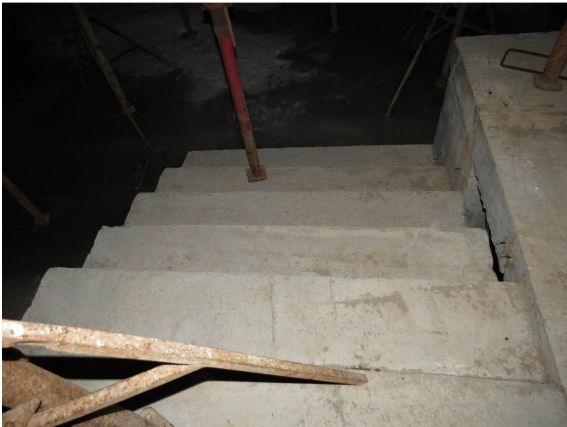
Рис. 3.5.1. Общий вид смонтированной монолитной одномаршевой лестницы, расположенной в зоне подвального этажа между осями Б/2-В/2 по оси 5
