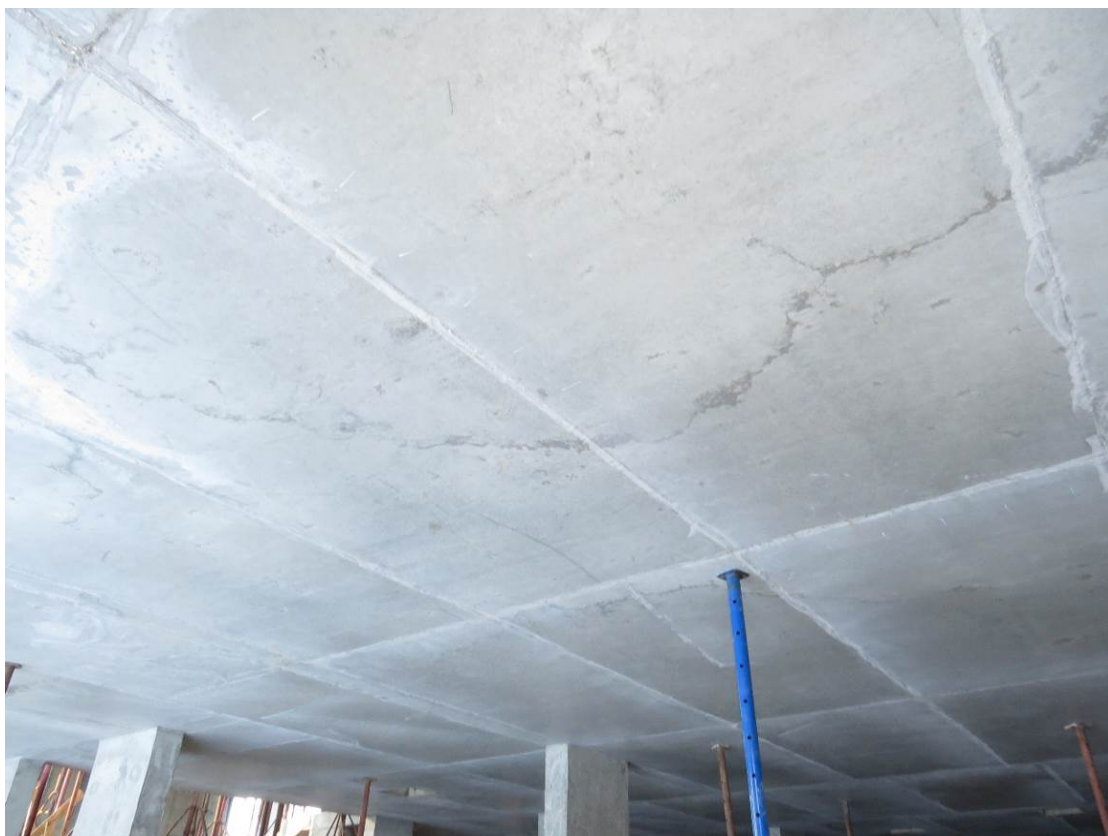
Рис. 3.3.1. Общий вид монолитной ж.б. плиты перекрытия подвала
