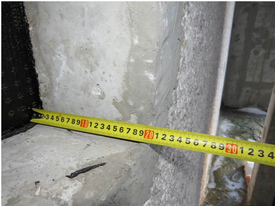
Рис. 2.1. Замер толщины монолитной ж.б. наружной стены здания в уровне подвального этажа при помощи металлической рулетки
