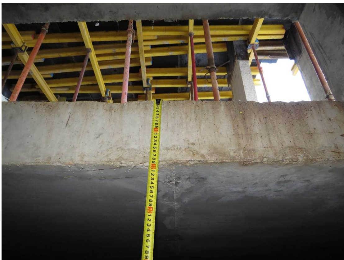
Рис. 3.3.2. Замер толщины монолитной ж.б. плиты перекрытия
