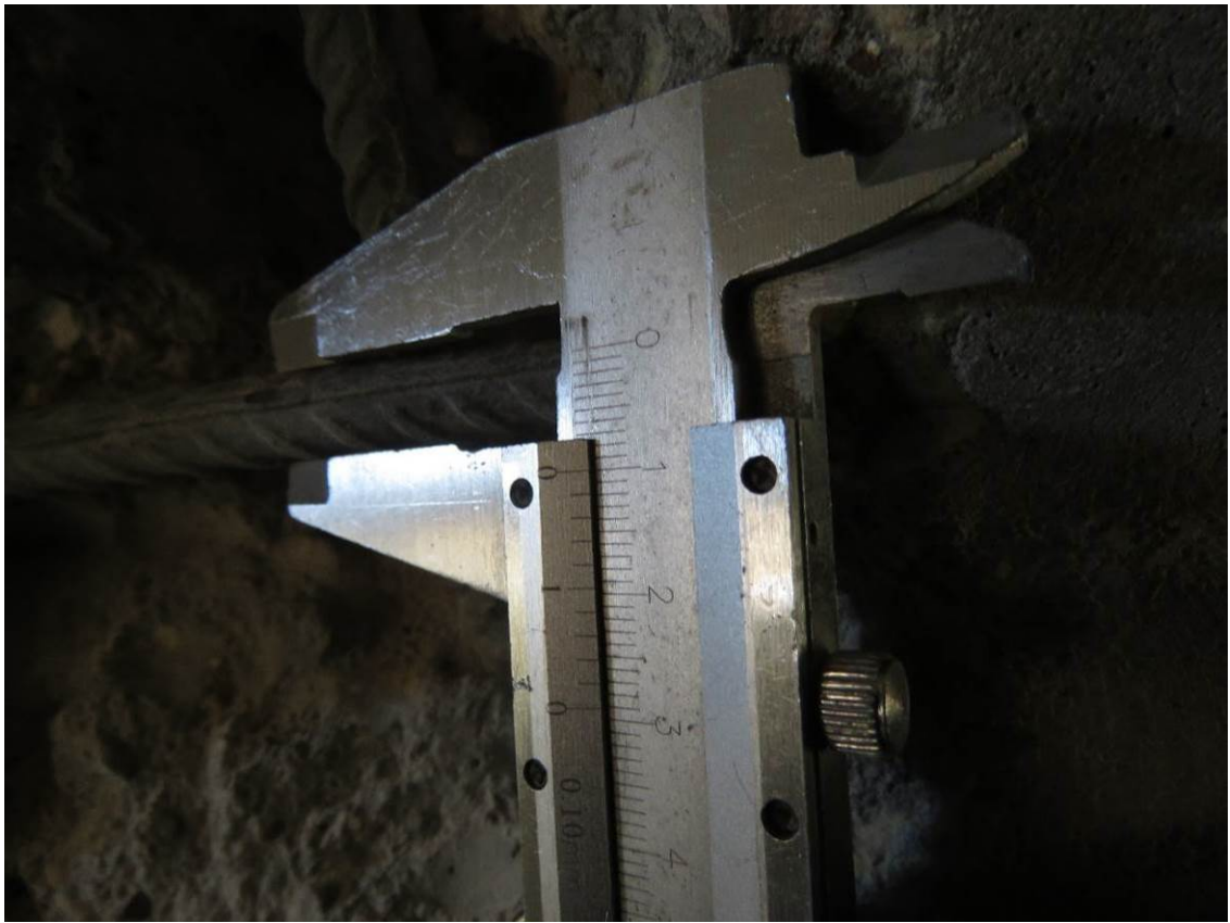
Рис. 3.2.3. Замер диаметра горизонтального армирования пилона на отм. -3,300 м
