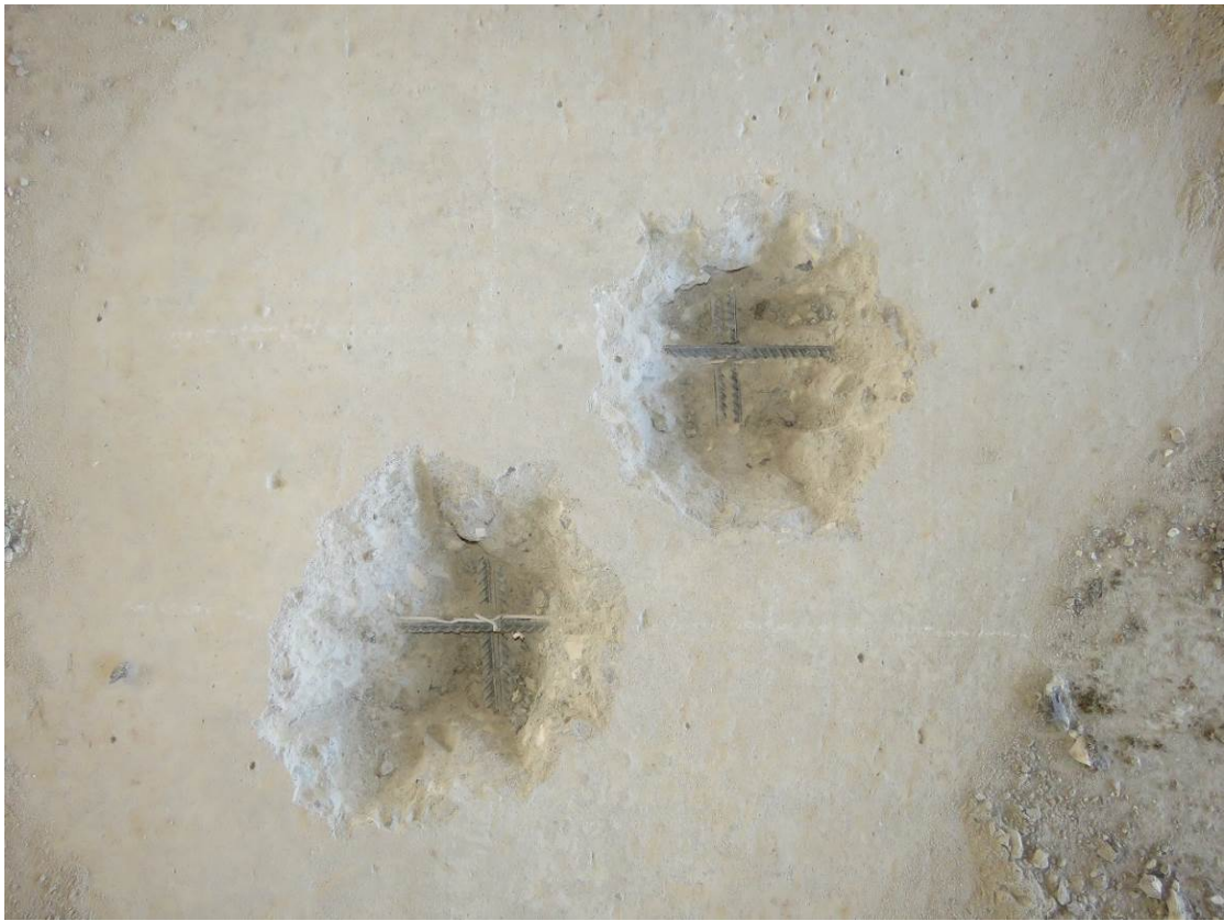
Рис. 3.3.5. Общий вид участка вскрытия монолитной ж.б. плиты перекрытия подвала между осями А/1-Б/1 и 7-8 (зона верхнего армирования)
