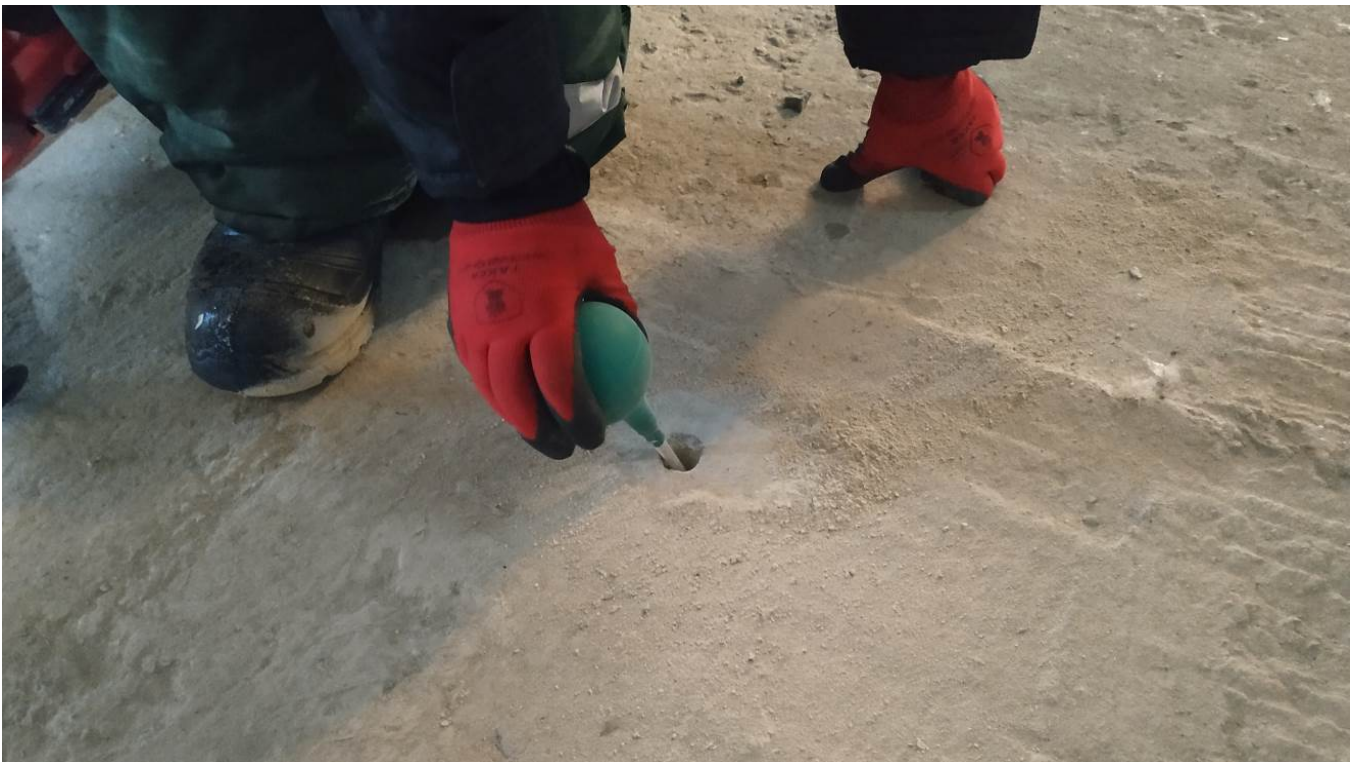
Рис. 4.2.2 . Продувка отверстия от пыли в монолитной железобетонной фундаментной плите в осях 3-4/Б/2-А/2
