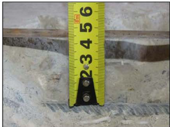
ФОТО 12. Уточнение защитного слоя бетона напольной поверхности плиты перекрытия подвала расположенной между осями «В/2»-«Г/2» и «7»-«8».
