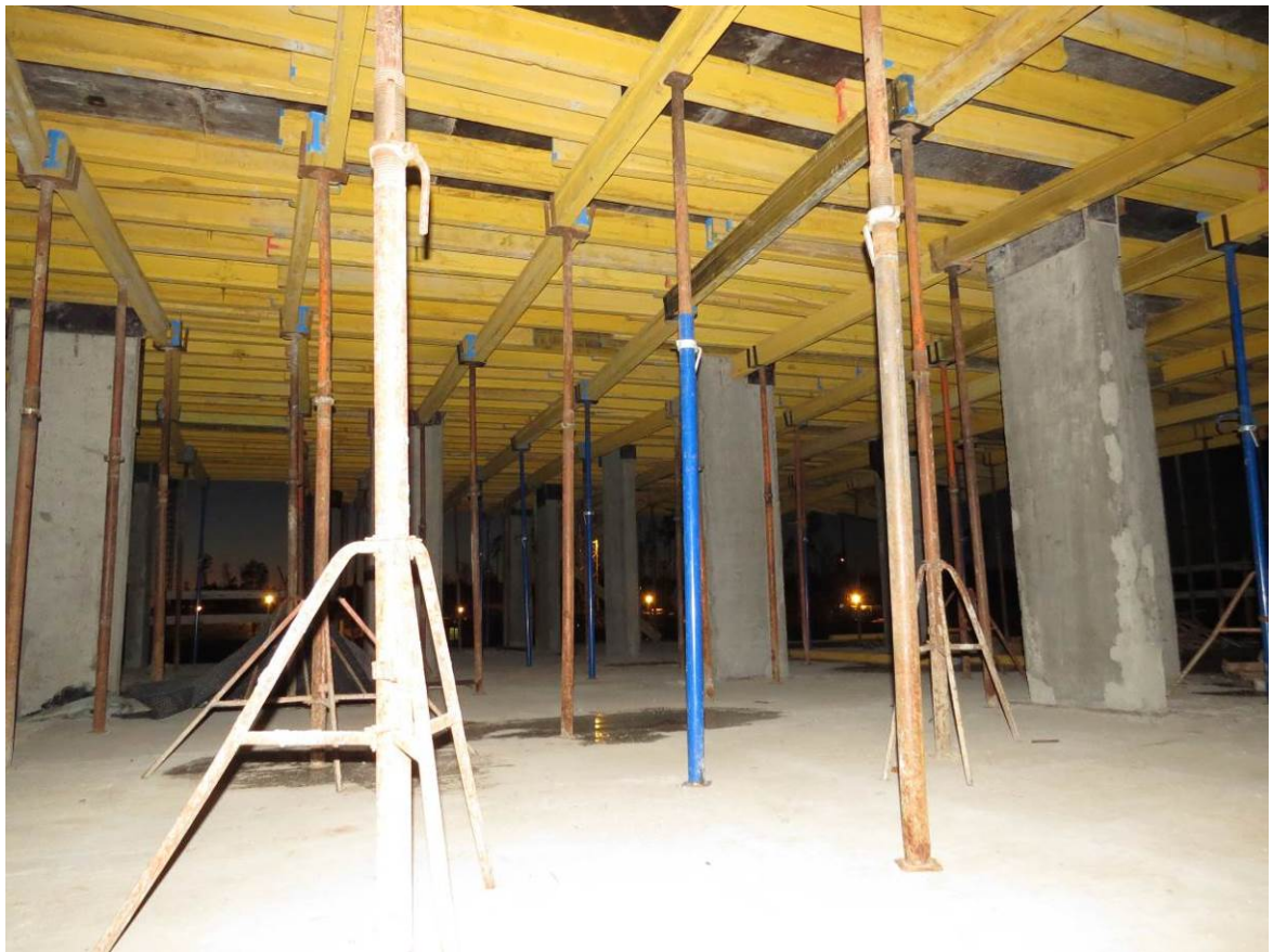
Рис. 1.6. Общий вид внутреннего пространства первого этажа секции №5
