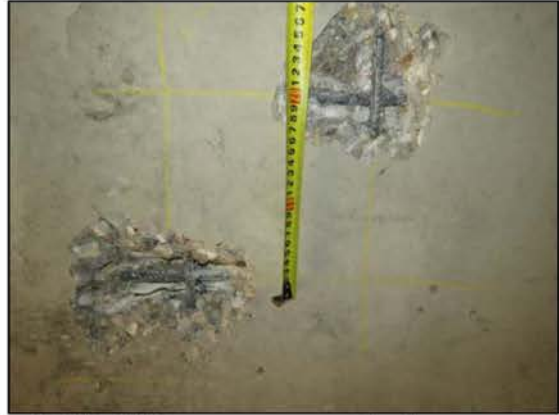
ФОТО 10. Уточнение шага рабочей арматуры потолочной поверхности монолитной ж/б плиты перекрытия подвала между осями «Я»-«А/1» и «8»-«10».
