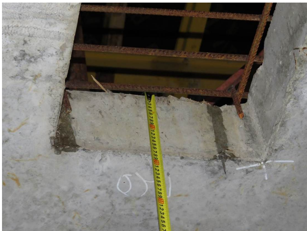
Рис. 2.2. Замер толщины плиты перекрытия подвального этажа секции №5
