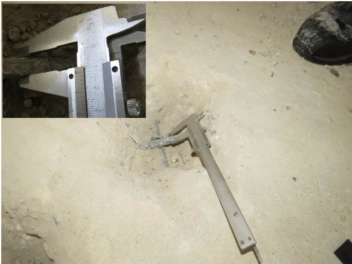
Рис. 3.1.6. Определение диаметра (12 мм) арматуры верхней зоны армирования фундаментной плиты между секцией 4 и 5 между осями В2-Г2, 7-8
