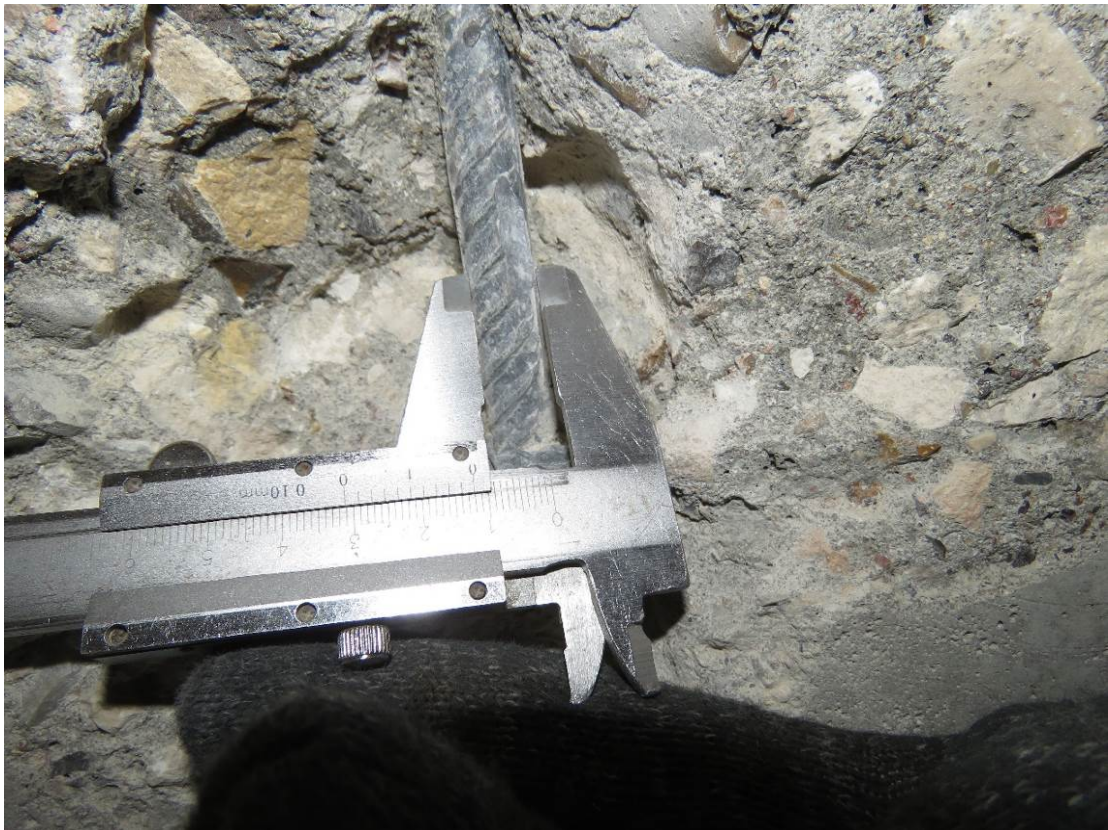
Рис. 3.2.2. Замер диаметра вертикального армирования стены на отм. -3,300 м
