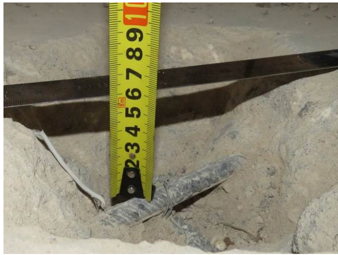
Рис. 3.1.7. Определение толщины (60 мм) защитного слоя бетона верхнего армирования фундаментной плиты между секцией 4 и 5 между осями В2-Г2, 7-8
