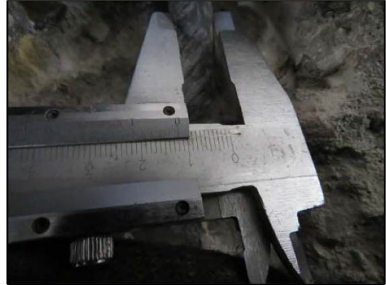
ФОТО 2. Уточнение диаметра рабочей арматуры монолитной ж/б стены подвала по оси «Б/1» между осями «7» и «8».
