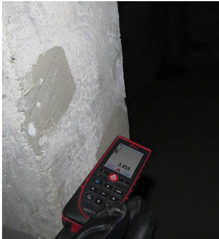
Рис. 2.3. Замер шага пилонов этажа при помощи лазерного дальномера Leica DISTO D410
