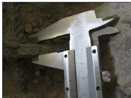
ФОТО 8. Уточнение диаметра рабочей арматуры поверхности пола монолитной железобетонной фундаментной плиты расположенной по оси «В/2» между осями «7»-«8».
