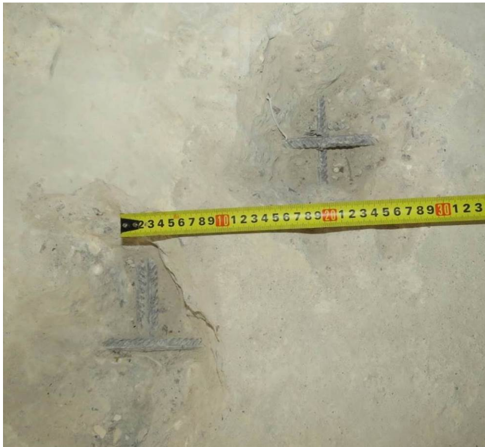
Рис. 3.1.4. Замер шага (200 мм) вдоль цифровых осей верхней зоны армирования фундаментной плиты между секцией 4 и 5 между осями В2-Г2, 7-8
