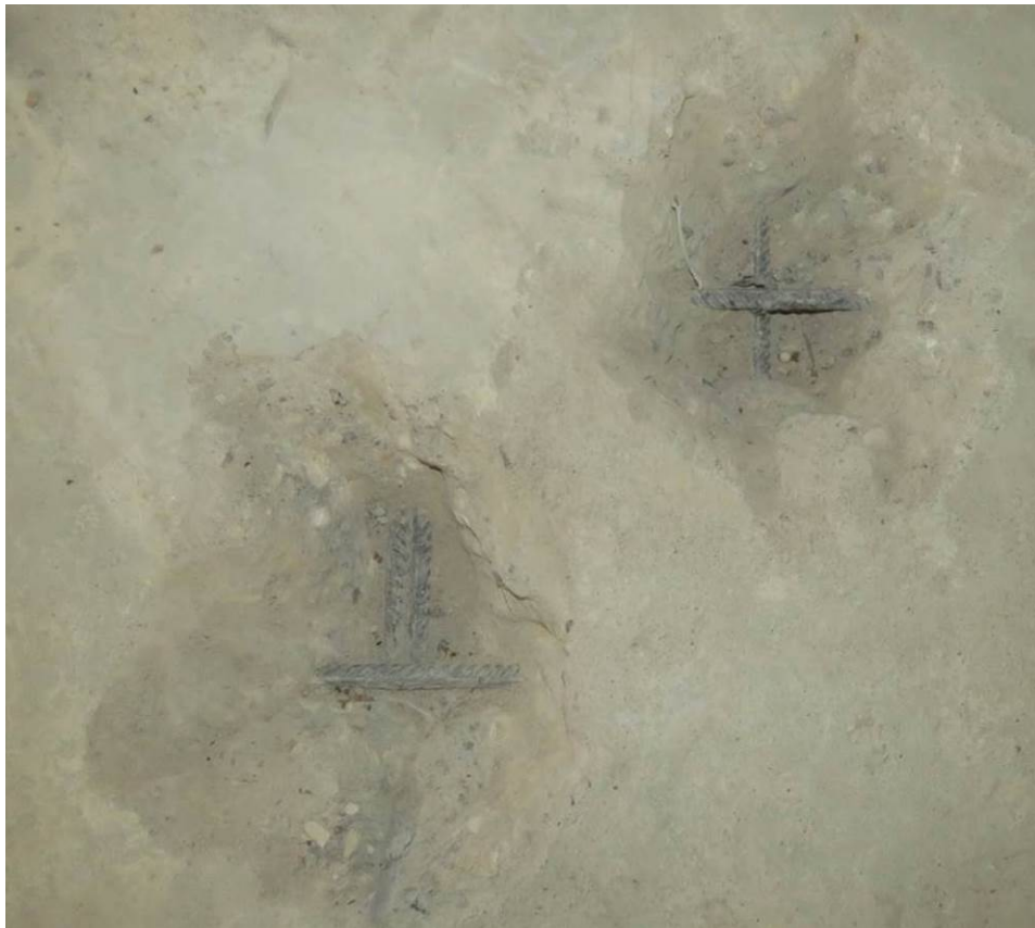
Рис. 3.1.3. Общий вид вскрытия фундаментной плиты между секцией 4 и 5 между осями В2-Г2, 7-8
