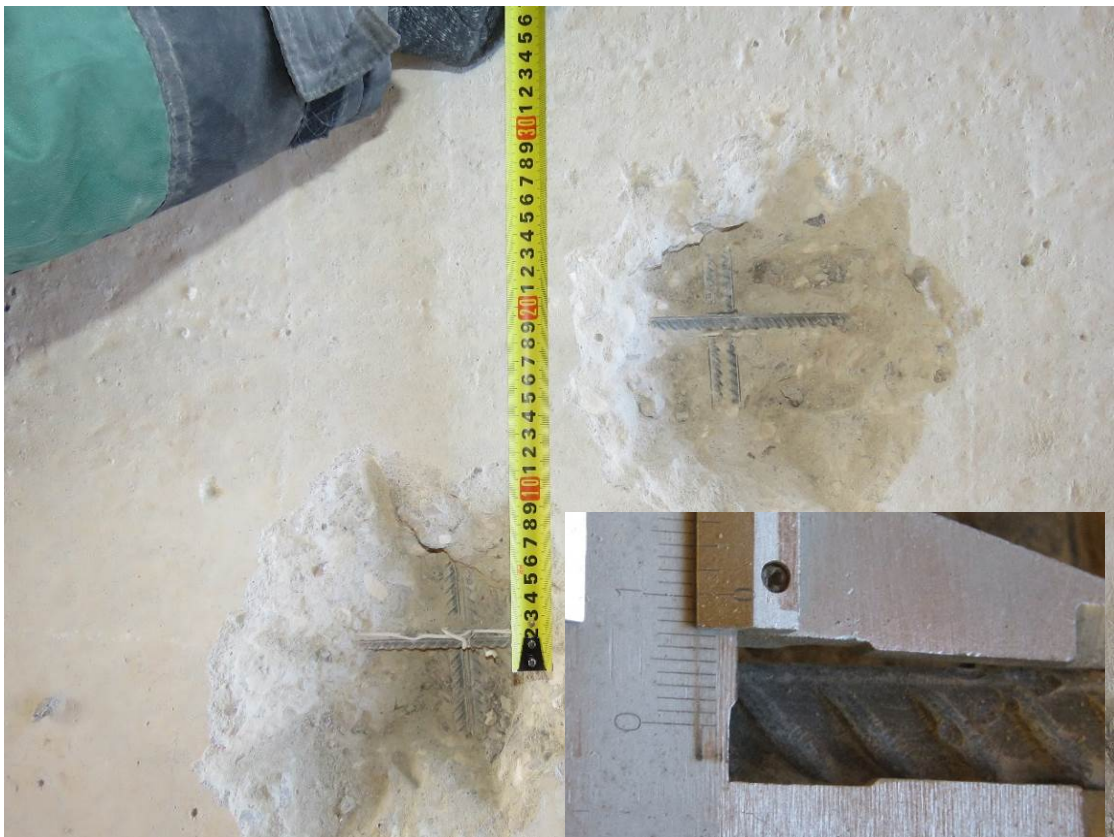
Рис. 3.3.6. Замер геометрических параметров верхнего армирования плиты перекрытия подвала
