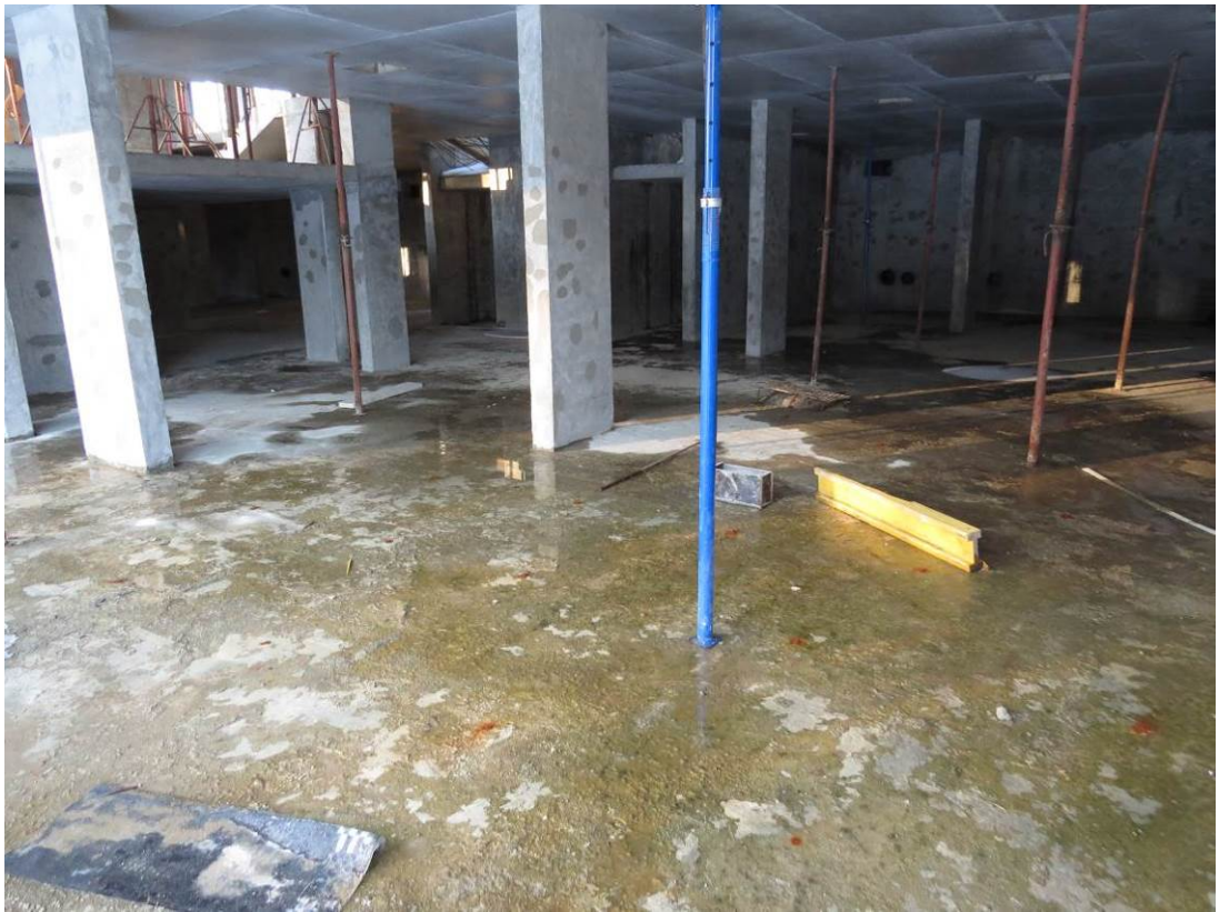
Рис. 1.5. Общий вид внутреннего пространства подвального этажа секции №4
