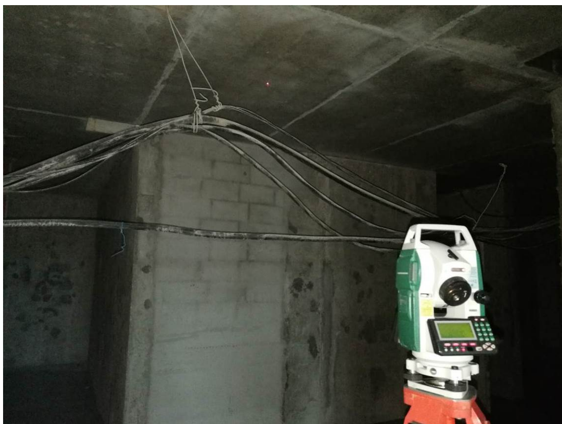
Рис. 2.6.1. Определение отклонений от вертикали и горизонтали строительных конструкций жилого здания при помощи электронного тахеометра «Sokkia RX-550»
