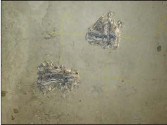
ФОТО 9. Общий вид вскрытия потолочной поверхности монолитной ж/б плиты перекрытия подвала расположенной между осями «Я»-«А/1» и «8»-«10».
