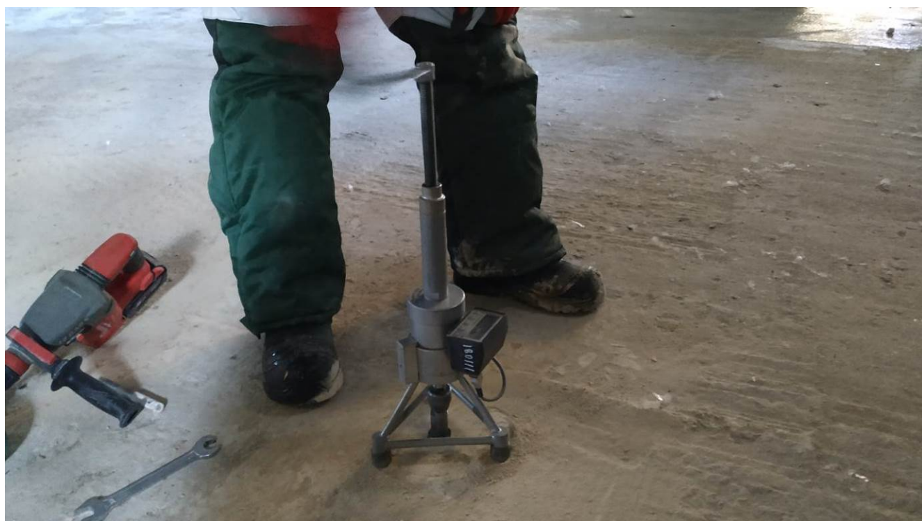
Рис. 4.2.4. Испытание бетона монолитной железобетонной фундаментной плите в осях 3-4/Б/2-А/2 методом отрыва со скалыванием прибором ПОС 50МГ-4
