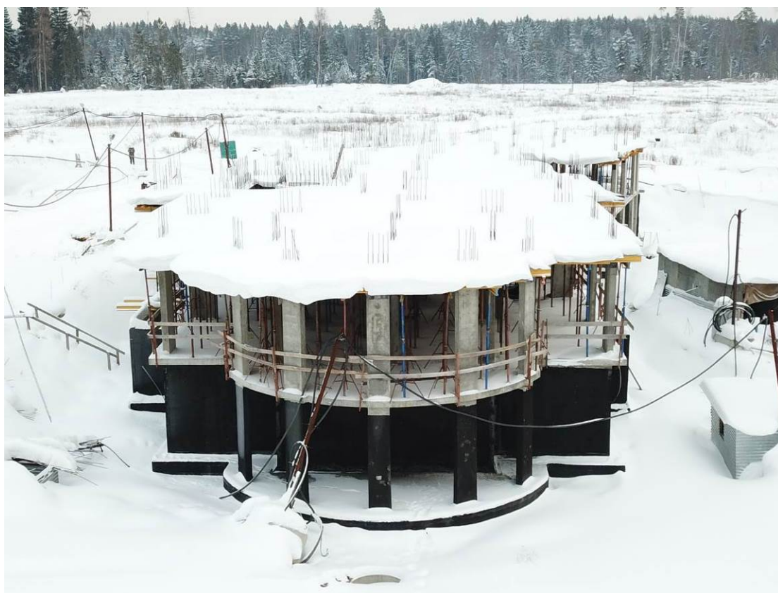
Рис. 1.4. Общий вид возведенных строительных конструкций по оси 1 между осями А/2-Е2 секции №5 жилого дома №11
