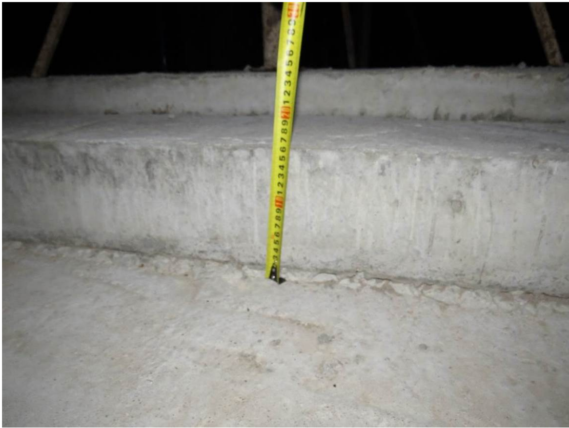
Рис. 3.5.3. Уточнение высоты подступенка лестничной конструкции, расположенной между осями Б/2-В/2 по оси 5
