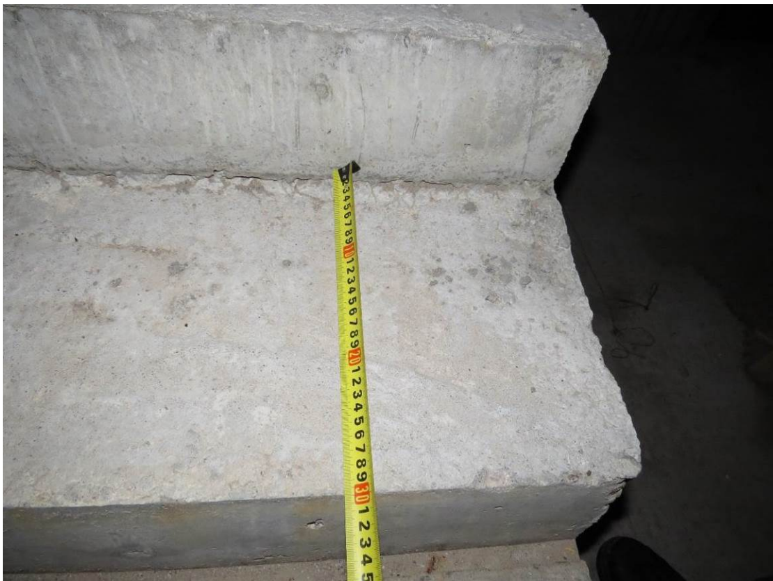
Рис. 3.5.3. Уточнение высоты подступенка лестничной конструкции, расположенной между осями Б/2-В/2 по оси 5
