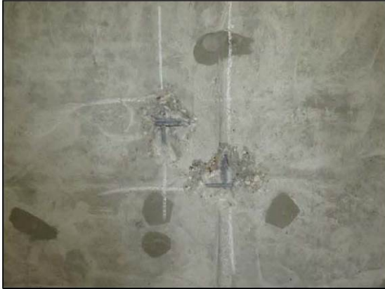
ФОТО 1. Общий вид вскрытия монолитной ж/б стены подвала по оси «Б/1» между осями «7» и «8».
