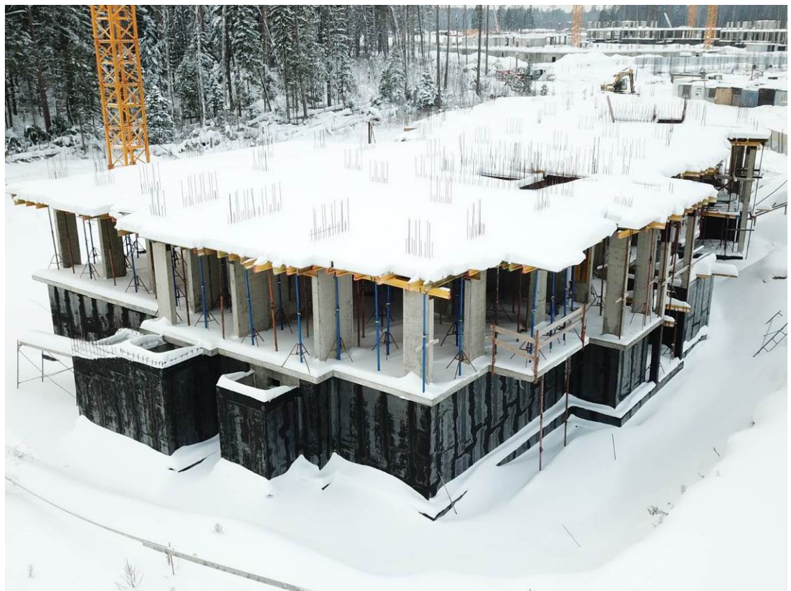
Рис. 1.2. Общий вид возведенных строительных конструкций секции №4 жилого дома №11
