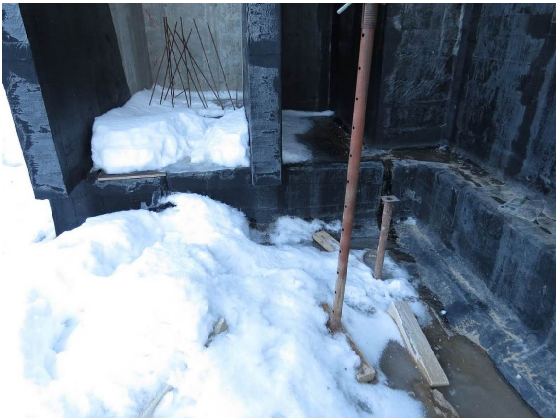
Рис. 3.1.1. Общий вид фундаментной плиты под наружную несущую монолитную ж.б. стену здания
