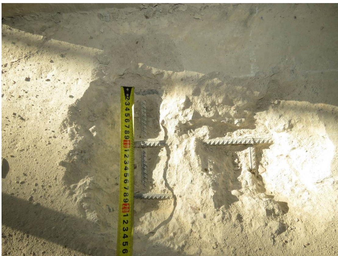
Рис. 3.3.4. Общий вид участка вскрытия монолитной ж.б. плиты перекрытия подвала в зоне пилона по оси 7 между осями Б/2-В/2 (зона верхнего армирования)
