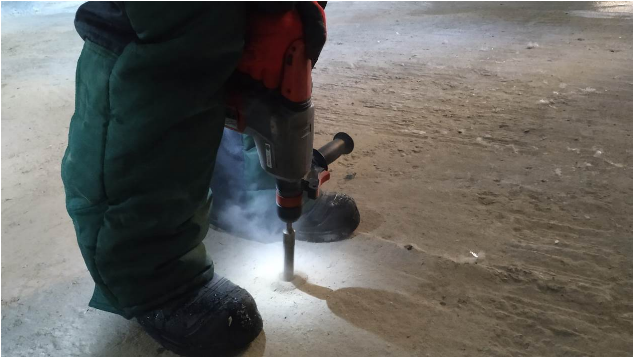
Рис. 4.2.1. Сверление отверстия в монолитной железобетонной фундаментной плите в осях 3-4/Б/2-А/2
