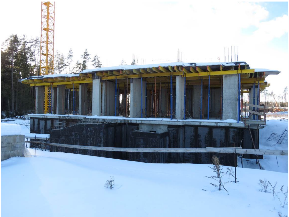
Рис. 1.1. Общий вид возведенных строительных конструкций секции №4 жилого дома №11 по оси 16 между осями Ю-В/1
