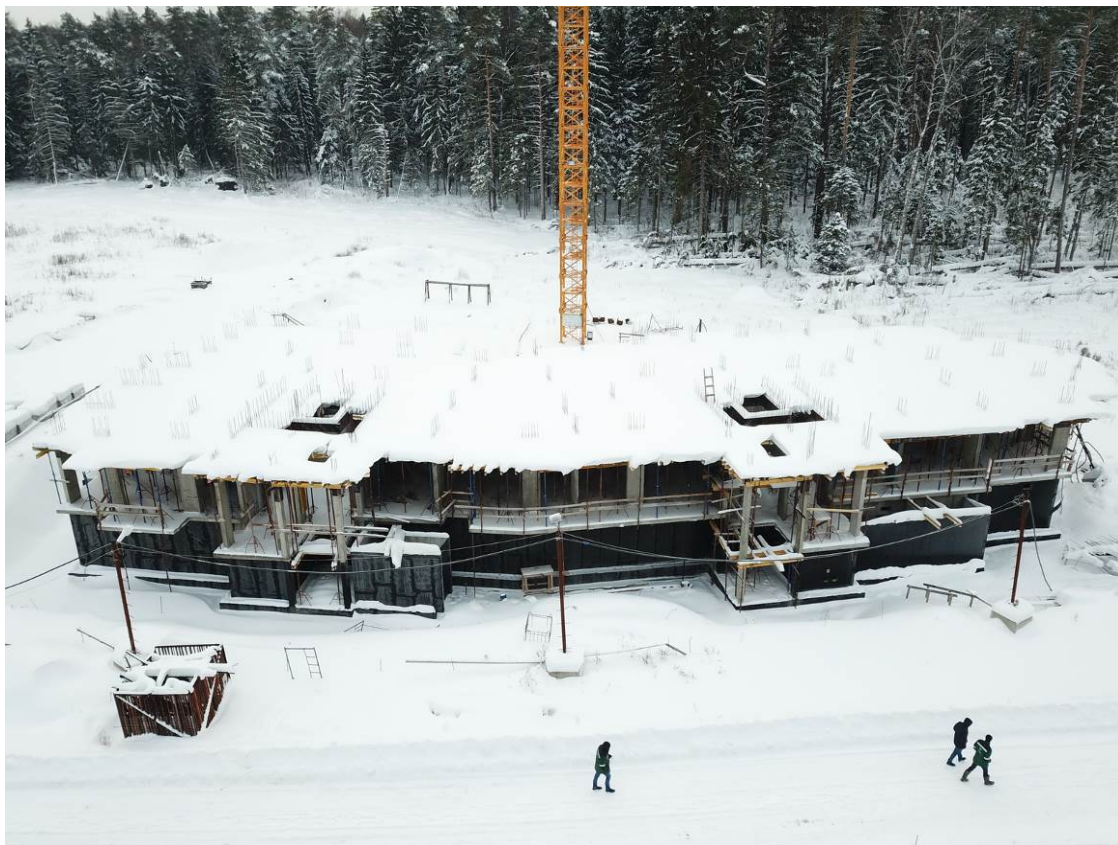
Рис. 1.3. Общий вид возведенных строительных конструкций по оси E2 между осями 1-7 секции №5 и по оси В/1 между осями 8-16 секции №4 жилого дома №11
