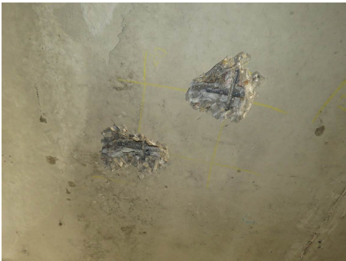
Рис. 3.3.3. Общий вид участка вскрытия монолитной ж.б. плиты перекрытия подвала между осями Я-А/1 и 8-10 (зона нижнего армирования)
