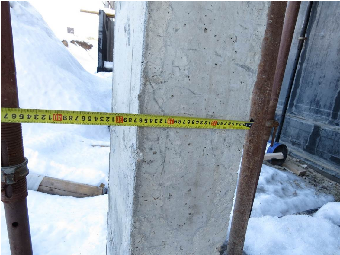
Рис. 3.2.1. Замер сечения монолитной ж.б. колонны на отм. -3.300 м между осями 8-11
